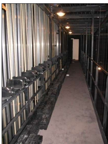
Passerelle de charge
