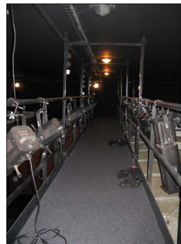
Passerelle centrale de salle
